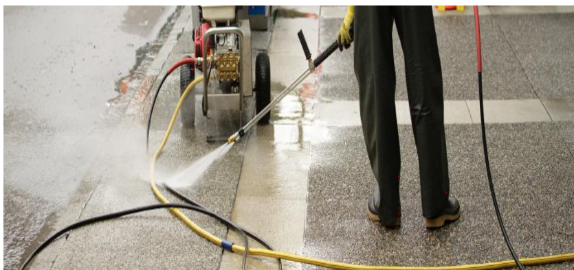
Obr. č. 5: Čištění podlah [16]
