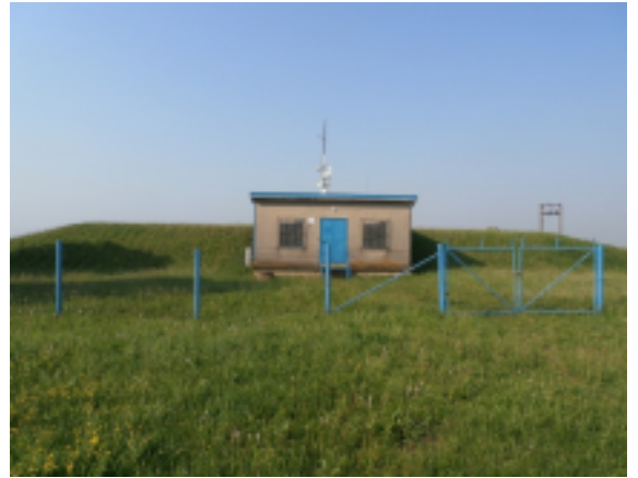
Obrázek 18: Vodojem (Zdroj: autor)
