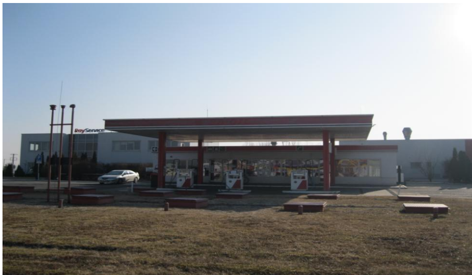
Obr. 5 Benzínová čerpací stanice B-Oil [zdroj:vlastní]
