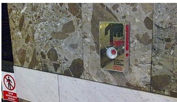
Obr. 22. Tísňové tlačítko ve stanici metra [18]
