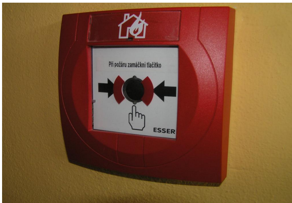
Obr. 5 Tlačítkový hlásič [12]
