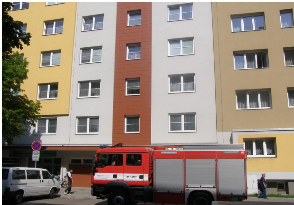
Obr. 9 Budova DPS po příjezdu jednotky HZS [12]
