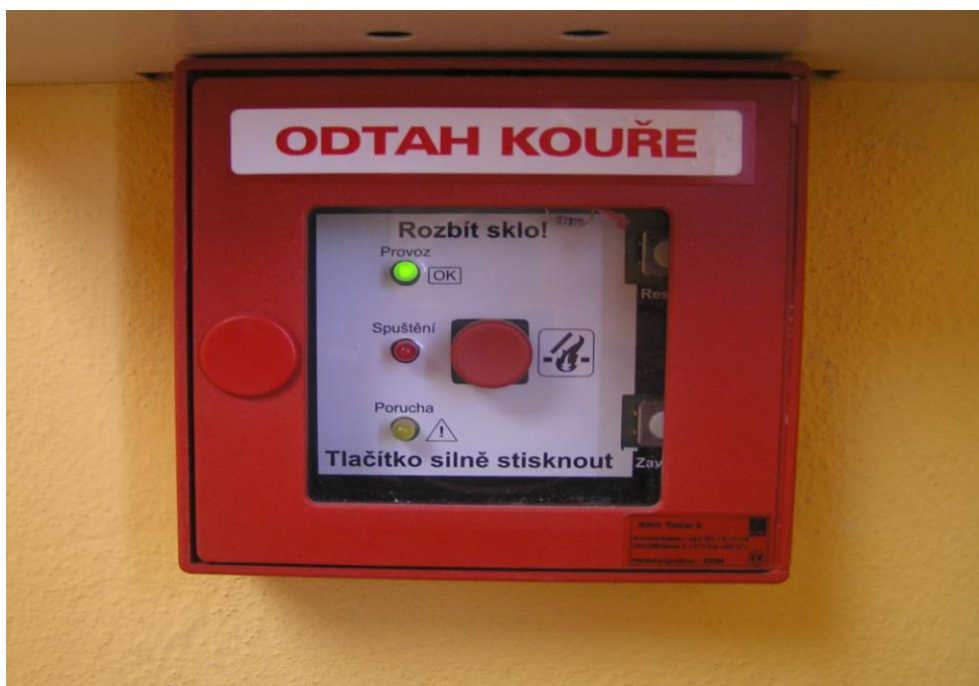
Obr. 8 Tlačítkový hlásič sloužící k restartu ovládání bodového světlíku [12]
