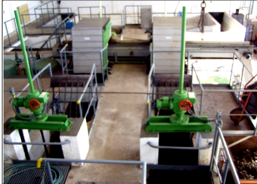
Obr. 2. Hrubé a jemné strojně stírané česle [6]
