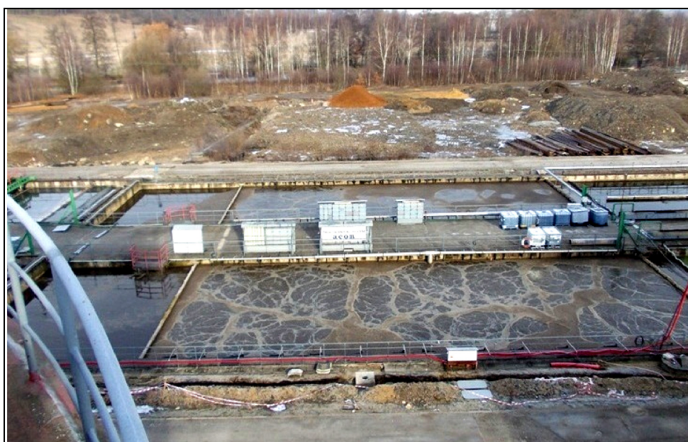
Obr. 5. Denitrifikace, rozdělující příčka, nitrifikace
