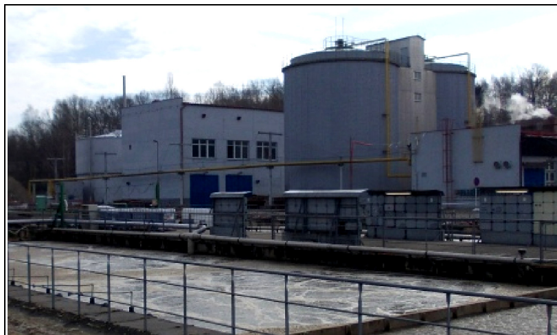
Obr. 6. Vyhnívací nádrže, strojní odvodnění, plynojem
