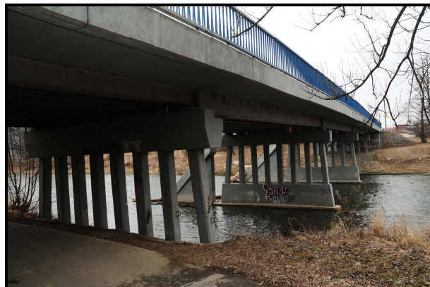
Obrázek 8 Most přes Vsetínskou Bečvu v Poličné [vlastní]
