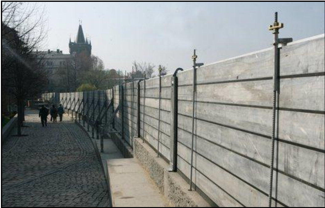
Obrázek 8 Protipovodňové hrzení [Zdroj:13]
