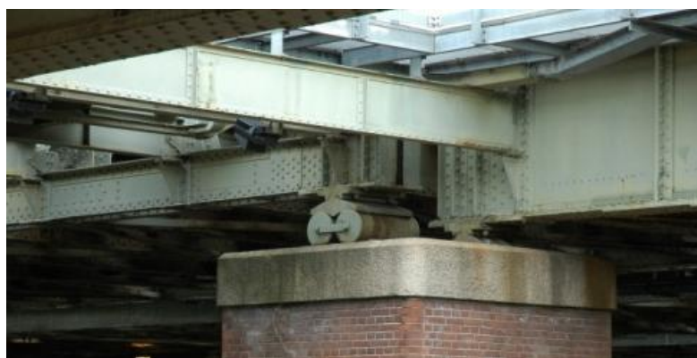
Obr. 14. Volné uložení mostní konstrukce na válčích
