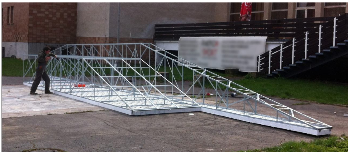
Obr. č. 62 Ukázka konstrukce překážek wakeboardů, (vlastní fotografie, 2012)
