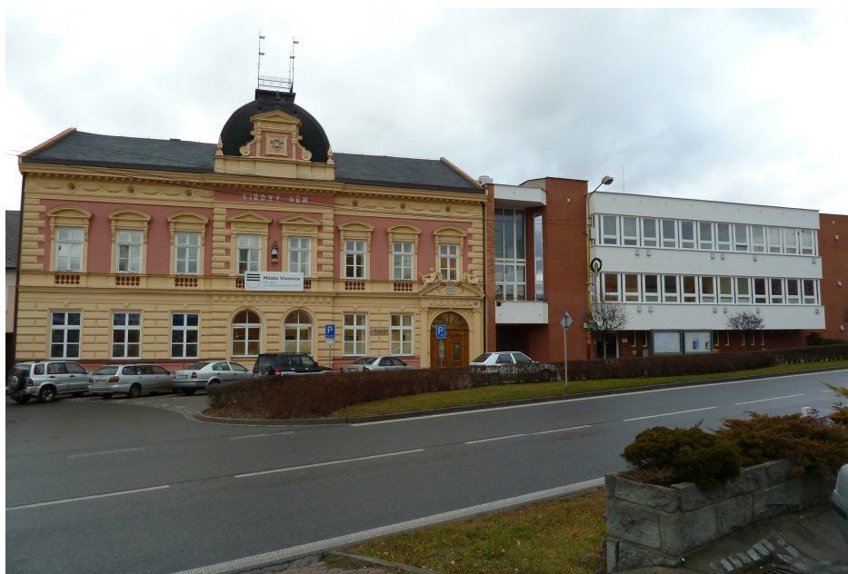
Obrázek 4: Budovy městského úřadu Vizovice (Město Vizovice, ©2012)
