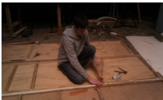
Obr. 9 Stavba pravé stěny
