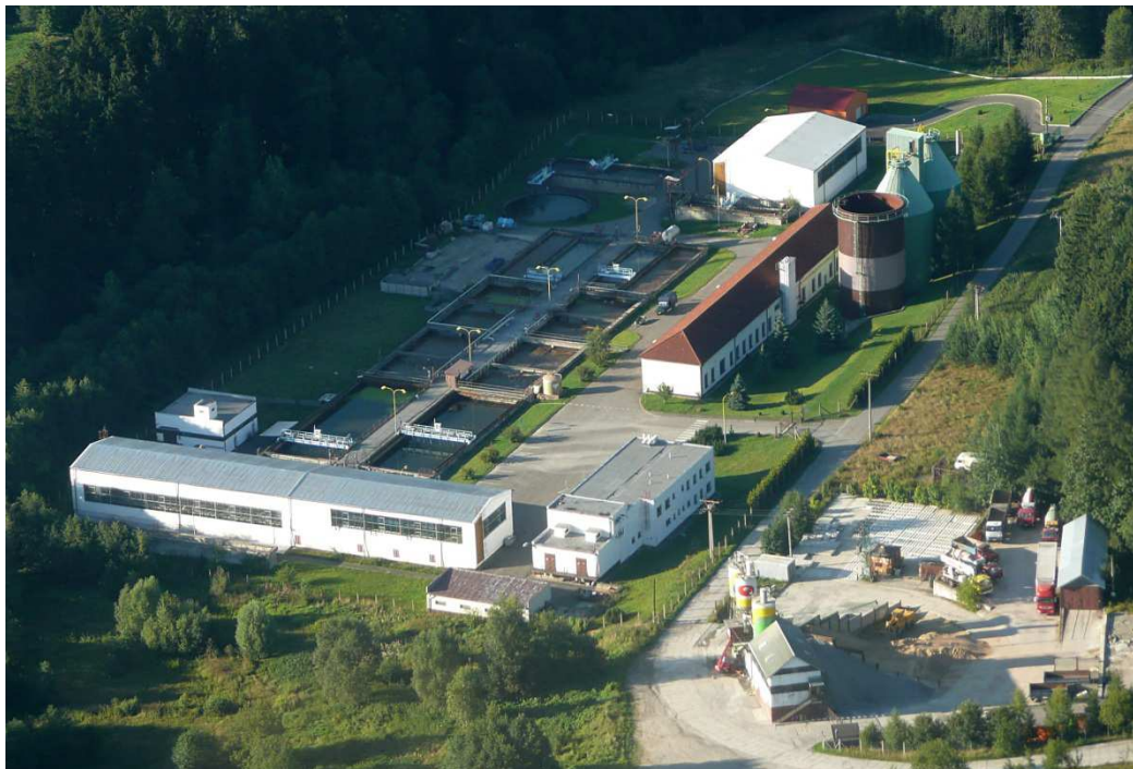
Obr. 1. ČOV Hlinsko – letecký pohled
