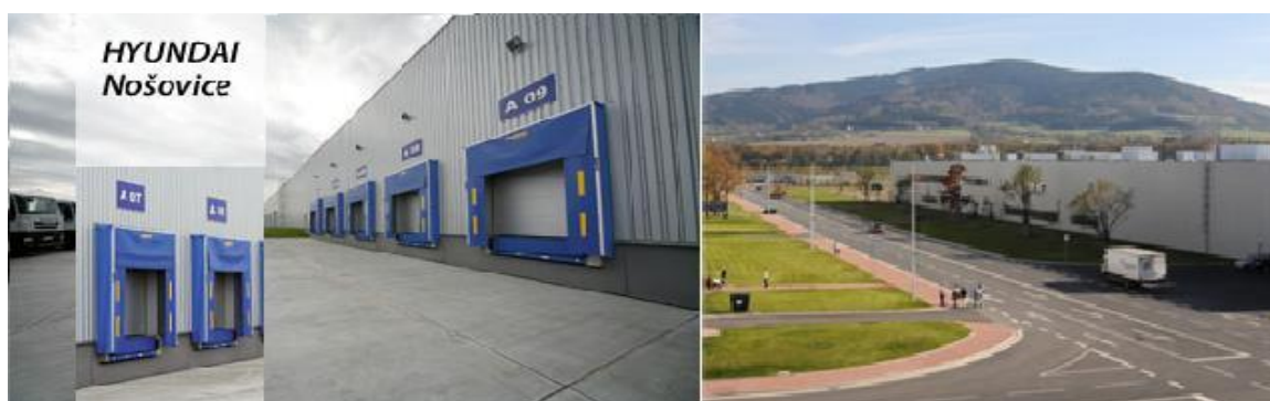
Obr. 24 – Výrobní hala Hyundai v Nošovicích
