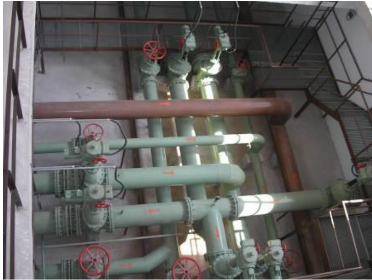
Obr. 6. Armatúrna komora vodojemu
