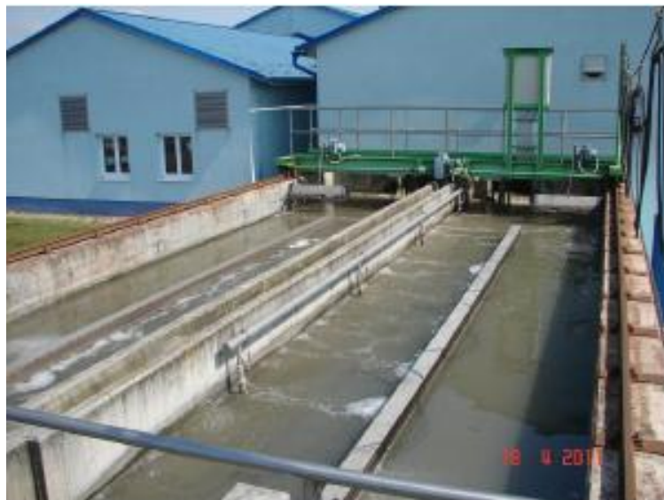
Obr. 12. Lapač piesku a tukov
