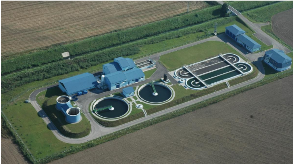
Obr. 10. ČOV Trenčín pravý breh
