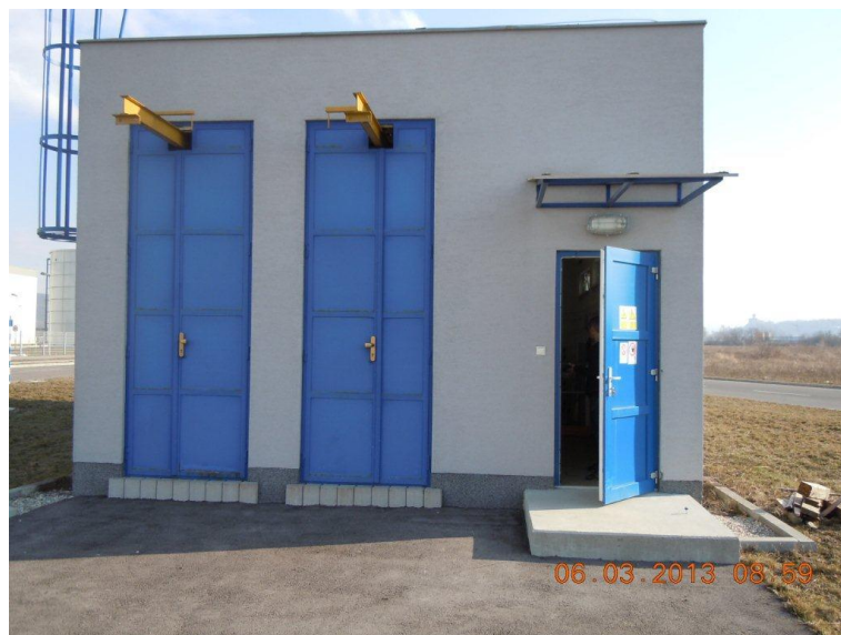
Obr. 8. Prečerpávacia stanica odpadových vôd
