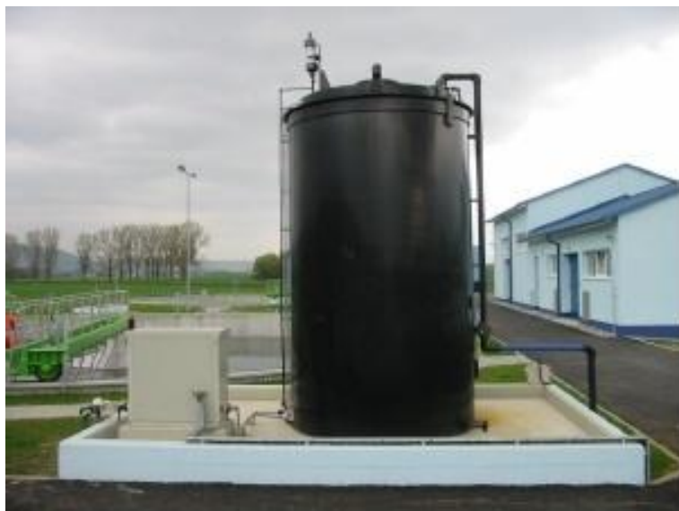
Obr. 15. Dávkovanie koagulantu
