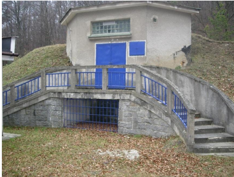
Obr. 5. Vodojem Baračka – Trenčianske Teplice
