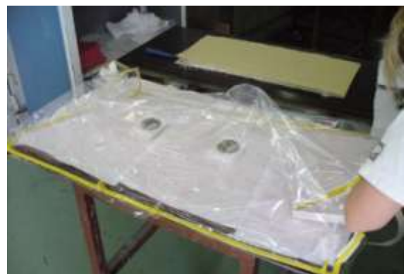
Obr. 48. Utěsnění vakuovací fólií
