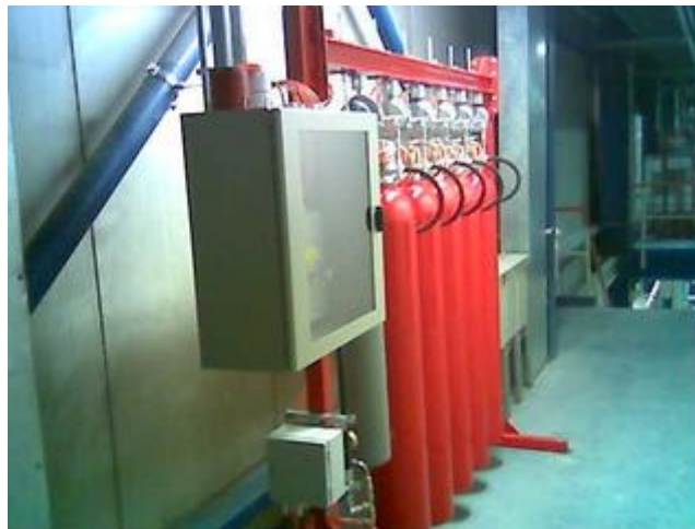
Obr. 14 Stanice SHZ CO 2 pro hlídku s centrálou a zpoždřovacím zařízením. [8]
