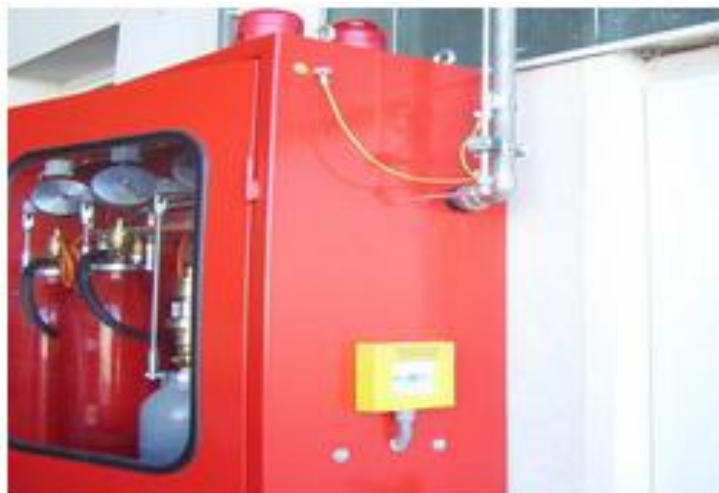
Obr. 13 Detail spínacího tlačítka SHZ [8]
