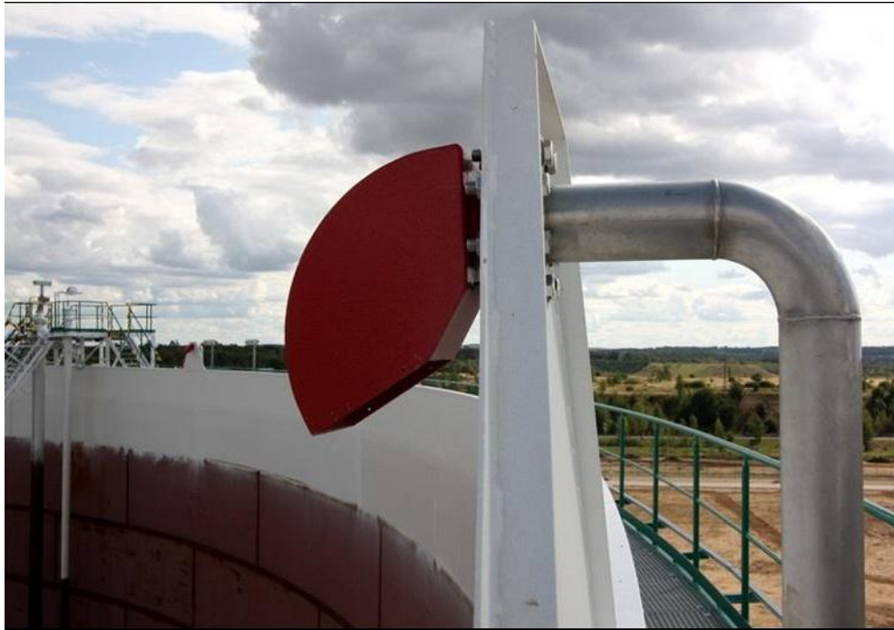
Obr. 8 Směrová hubice SHZ zásobníku ropy [7]
