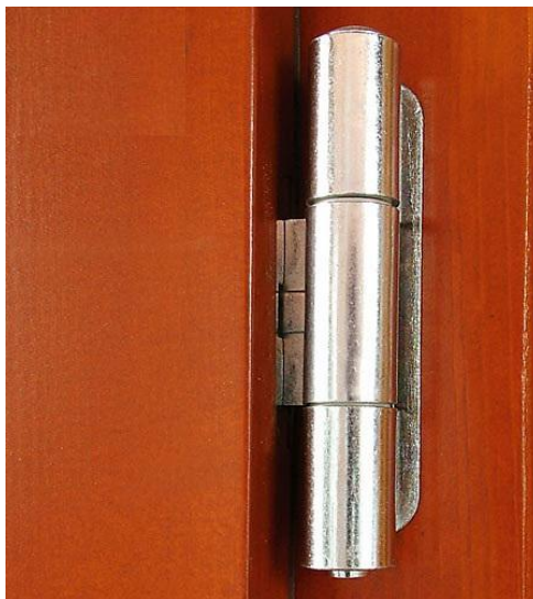
Obr. 6. Záves dverí zabezpečený proti vysadeniu [42]
