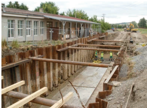
Obrázek 9 – Ukázka stavby larsenové stěny [19]
