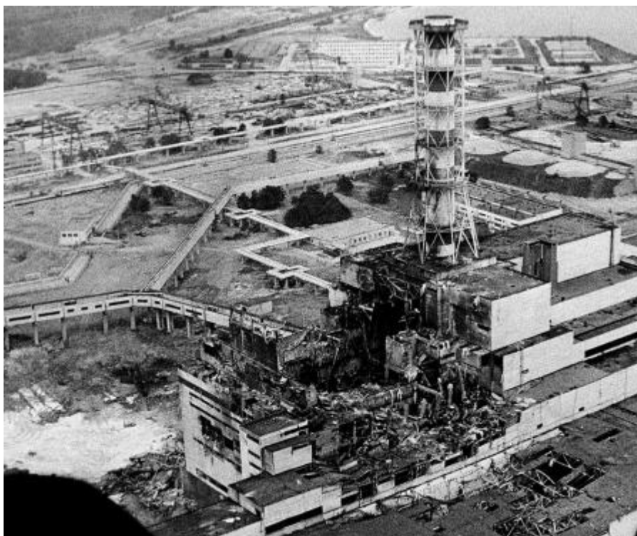
Obr. 3 Snímek explodovaného reaktoru před zakrytváním [12]
