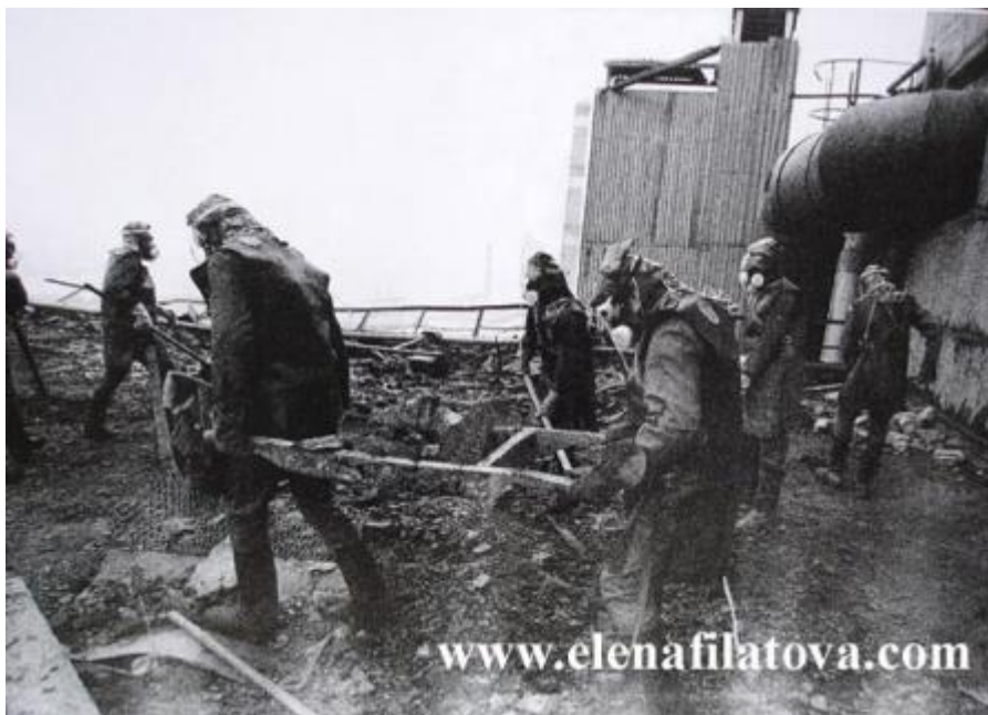
Obr. 5 "Bioroboti" na střeše reaktoru [12]
