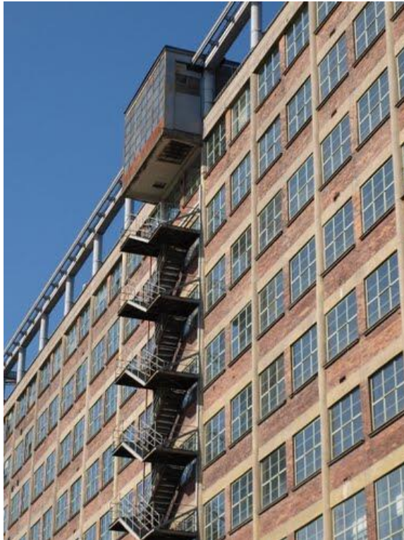
Obr. 21 Požární schodiště objektu [autor snímku L. Slávek Chybík]
