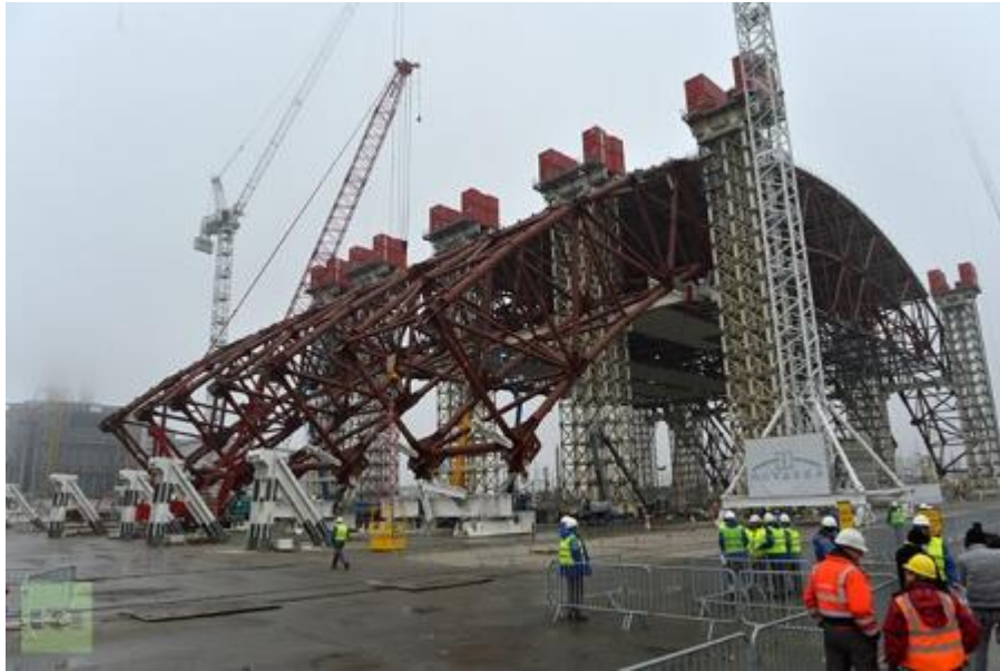
Obr. 6 První část nového sarkofágu [12]
