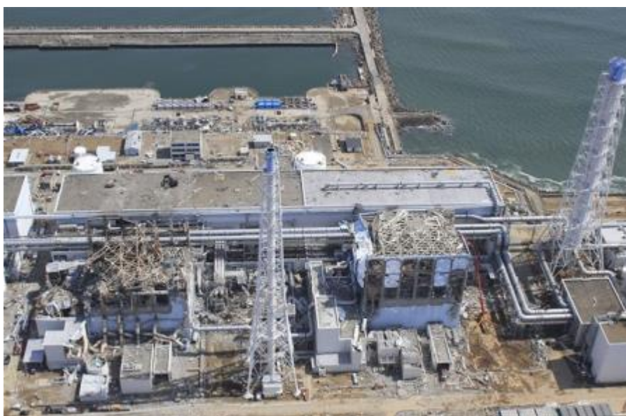
Obr. 7 Poškozené pomocné budovy Fukušimské elektrárny [12]
