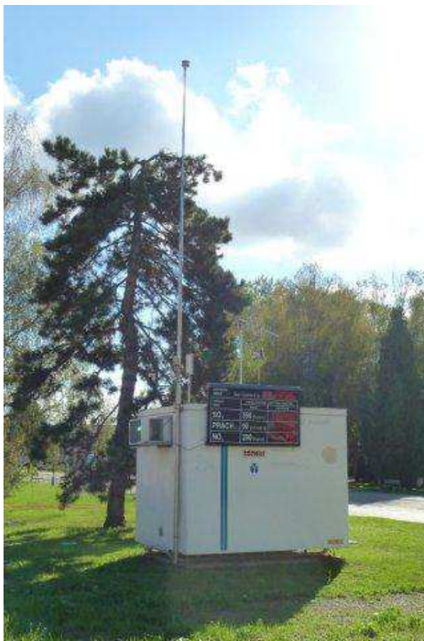
Obr. 5. Stacionární měřicí stanice – Uherské Hradiště.
