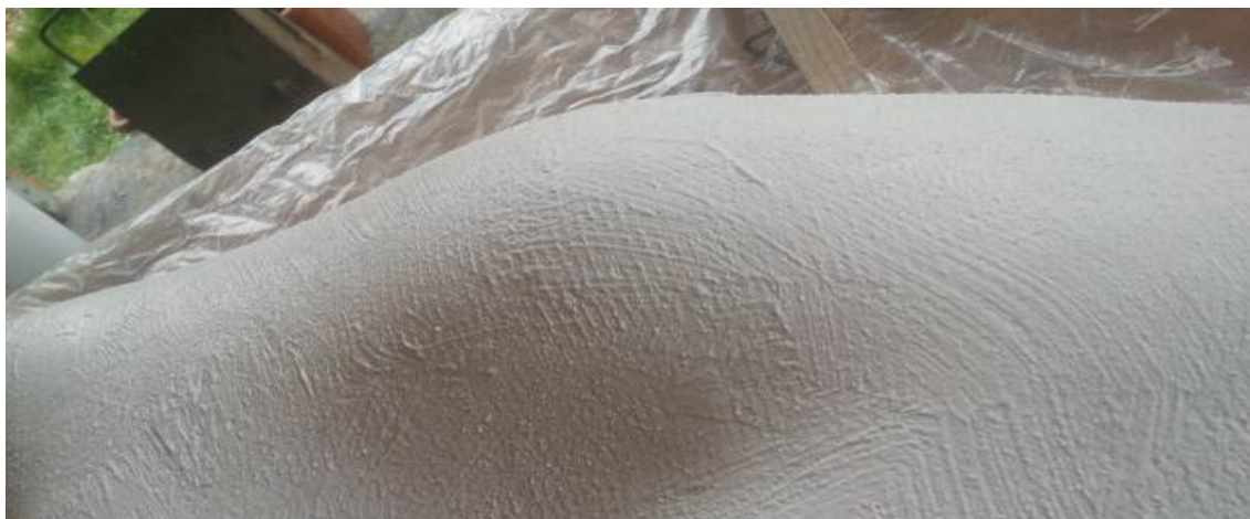
Obrázek 87. Drážky po frézování bylo nutné přesádrovat a vybrousit.
