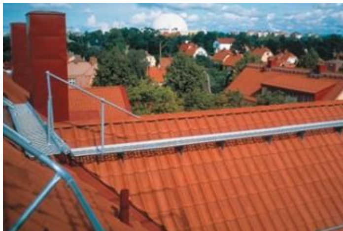
Obr. č. 20 Lávky a žebříky [11]
