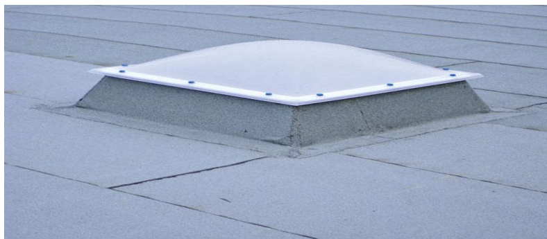
Obr. č. 10 Střešní asfaltová hydroizolace [14]
