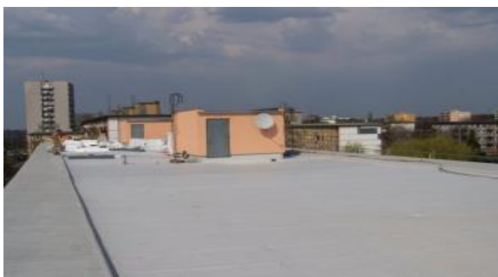
Obr. č. 11 Střešní foliová hydroizolace [14]
