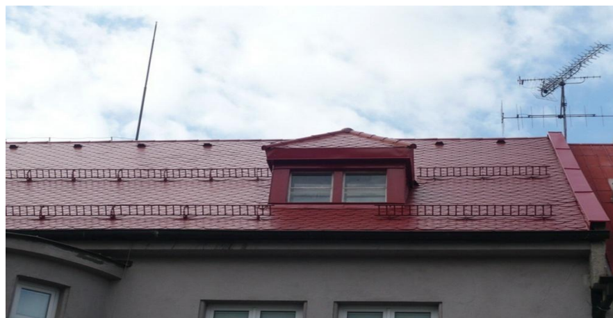
Obr. č. 21 Systém zdvojené sněhové zábrany
