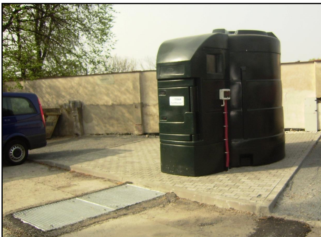
Obr. 12 – Čerpací stanice pohonných hmot.
