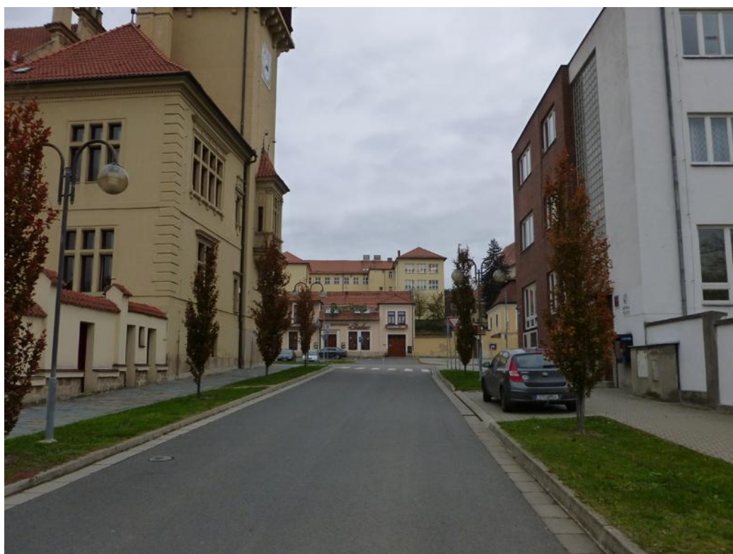
Obr. 41. Foto stávajícího stavu
