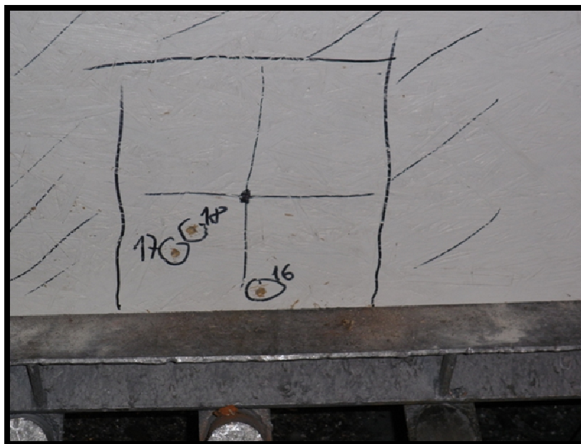
Obr. č. 50: OSB deska po měření
