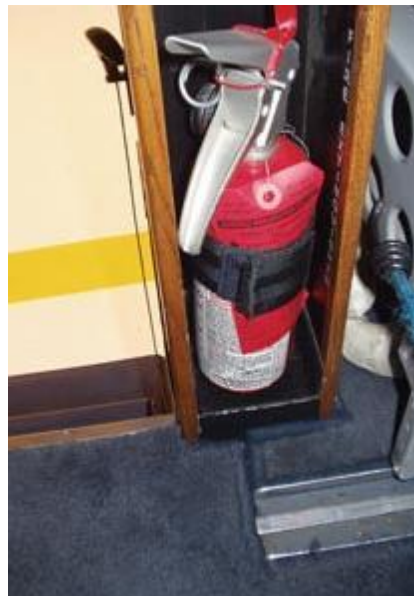
Obr. 26 Neadekvátne označenie a umiestnenie hasiaceho prístroja (vlastné spracovanie)
