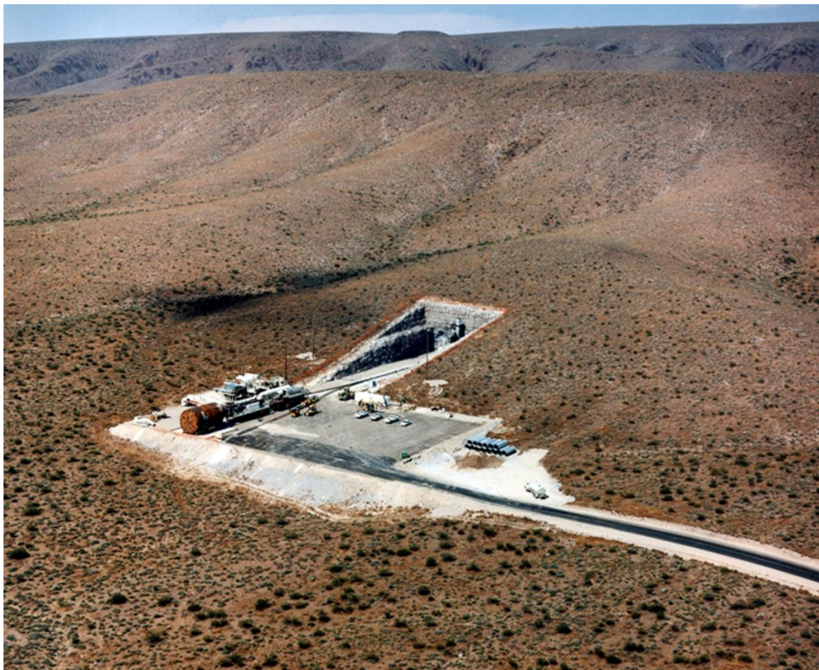
Obr. 4 – Vstup do úložiště Yucca Mountain z jižní strany [6]
