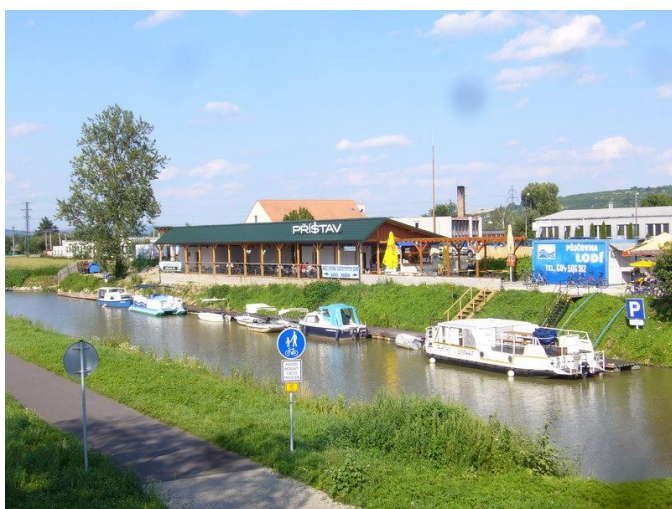
Obrázek 20- Přístaviště UH (Baťův kanál, 2014)
