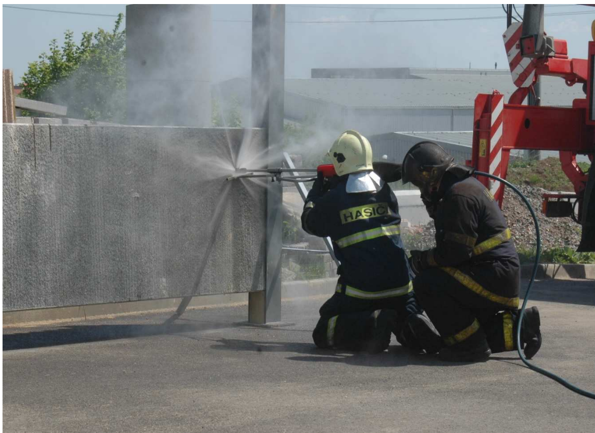
Obrázek č. 10. Řezání betonového panelu zařízením CCS Cobra při výuce na ŠVZ HZS ČR Brno
