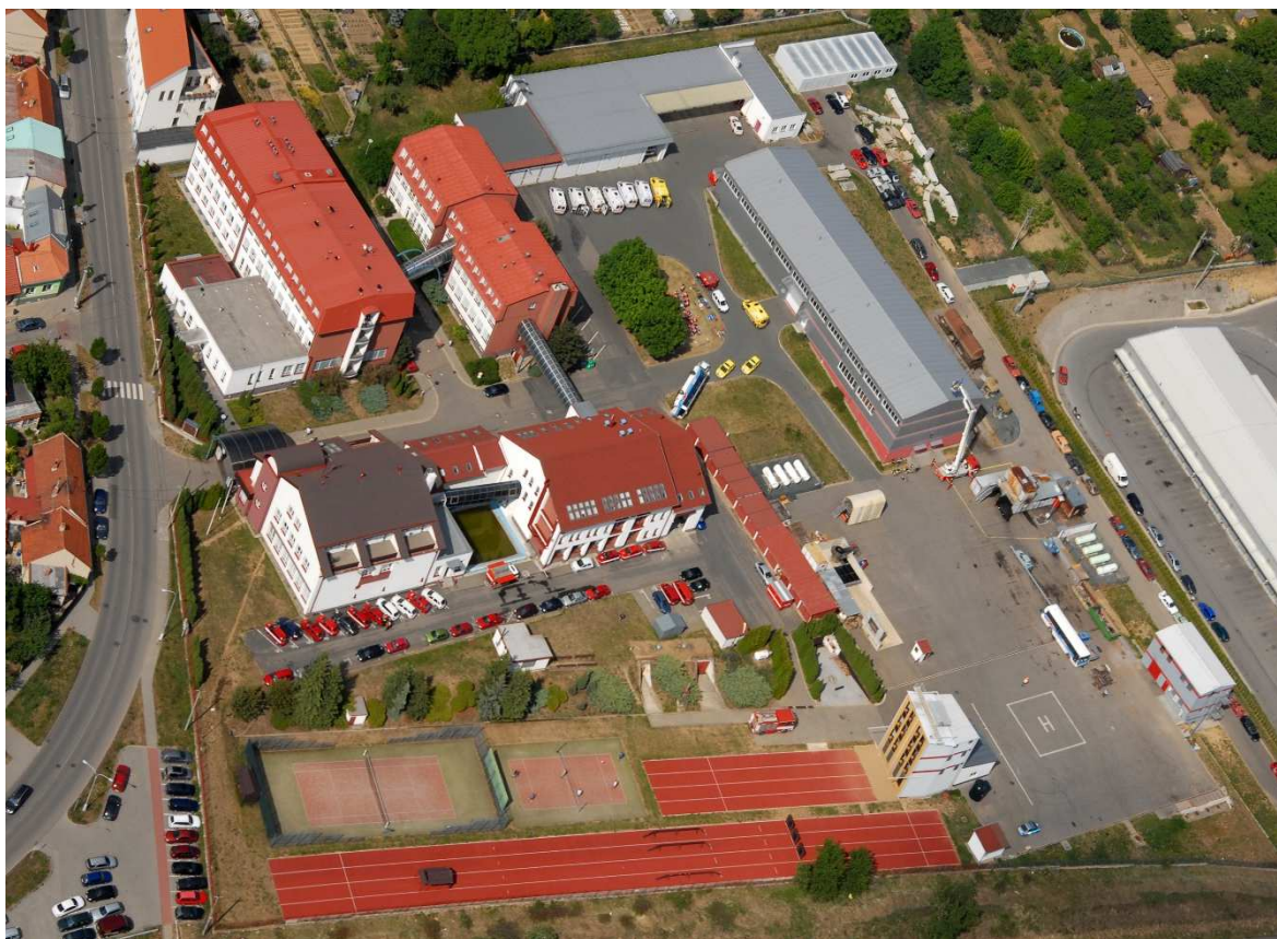
Obrázek č. 1. Letecký pohled na areál Školního a výcvikové zařízení HZS ČR Brno
