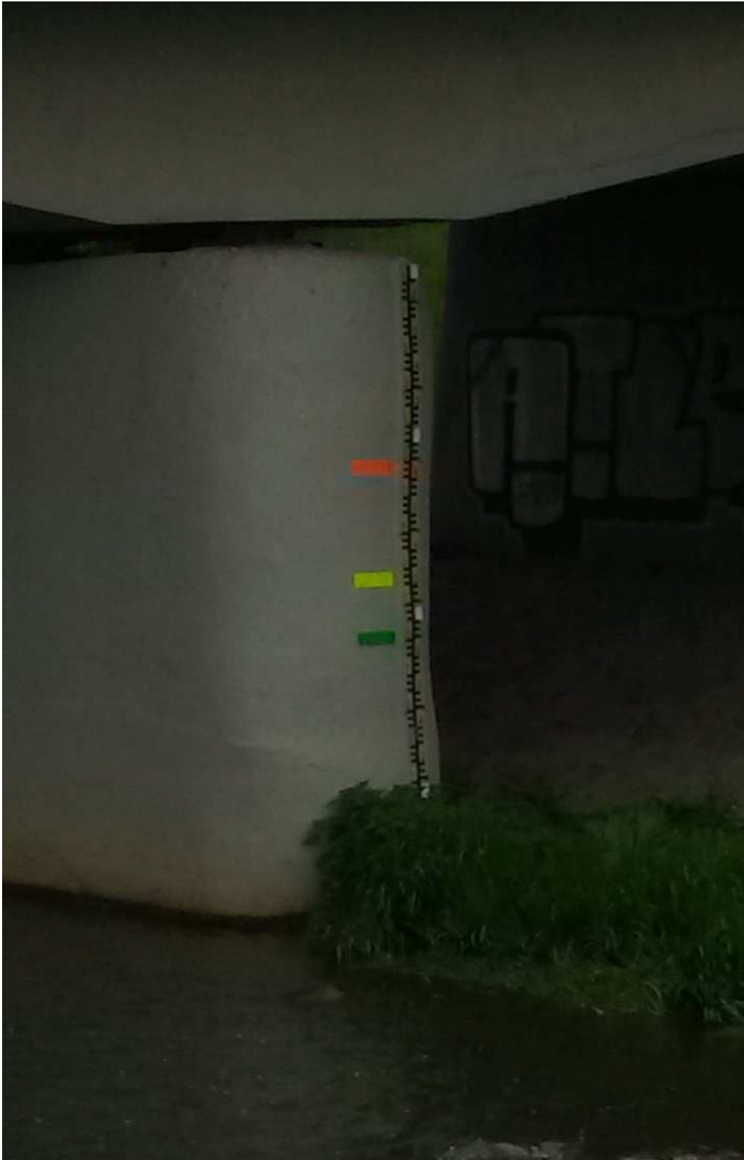
Obrázek 11: Vodotečná lať [Zdroj: vlastní]
