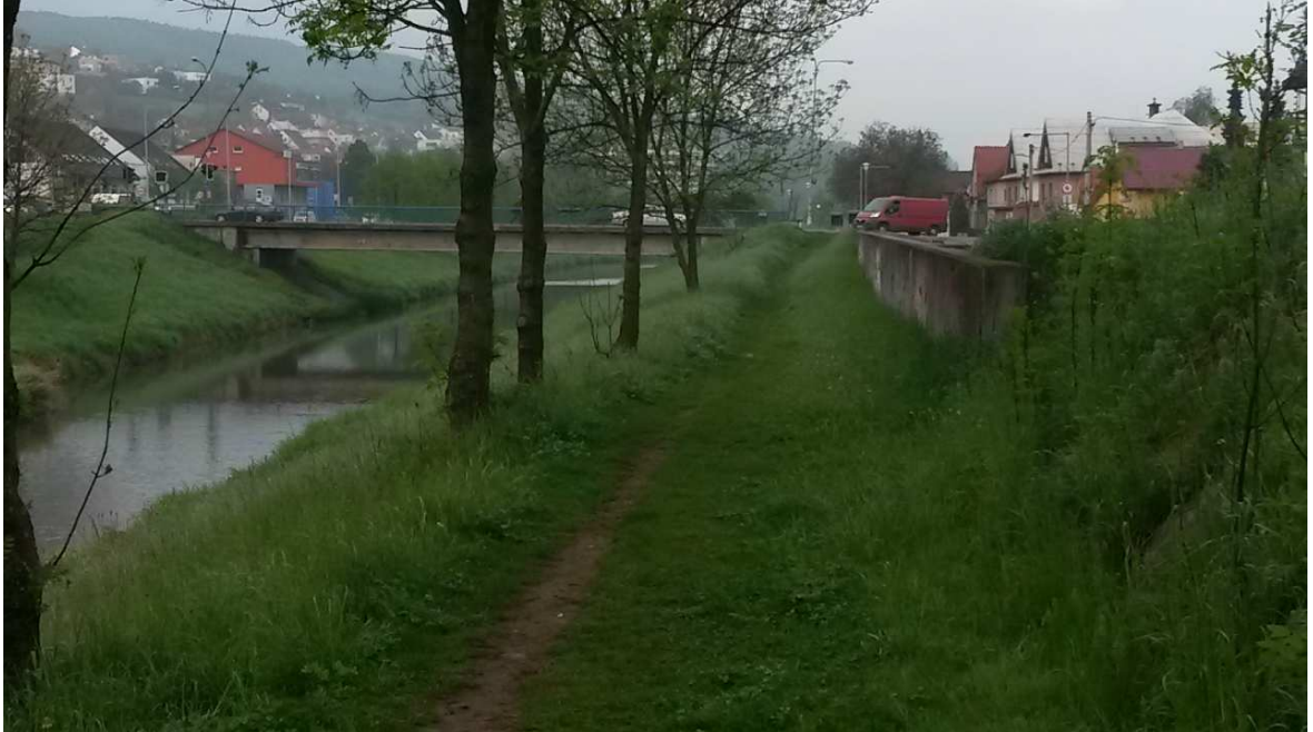
Obrázek 3: Zemní hráze a protipovodňová stěna - Příluk [Zdroj: vlastní]
