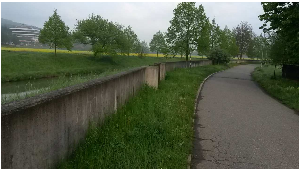
Obrázek 2: Protipovodňová stěna- Příluk [Zdroj: vlastní]
