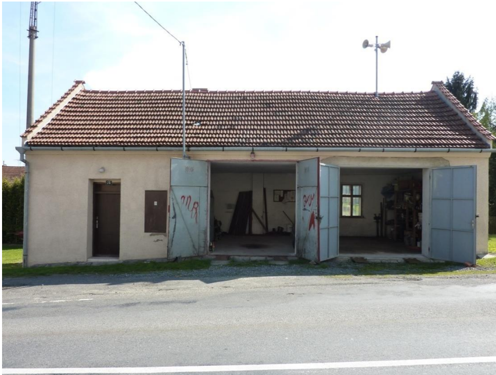
Foto: Hasičská zbrojnice
