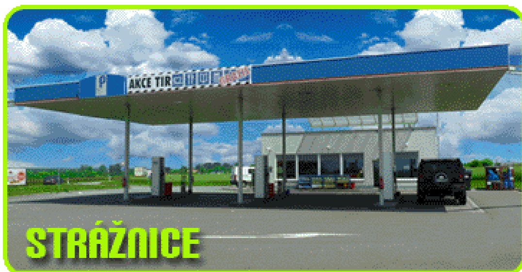
Obrázek č. 4 - Čerpací stanice Petrol Station ve Strážnici [22]
