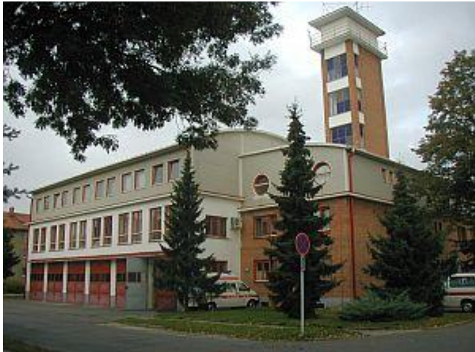
Obr. 5. Stanice HZS Uherské Hradiště [4]
