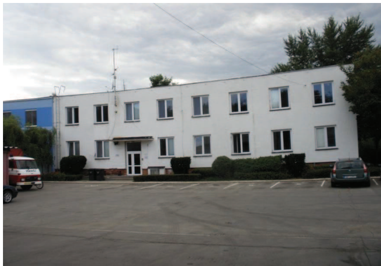
Obr. 5. Hlavní budova JPO HZS SŽDC Brno.
