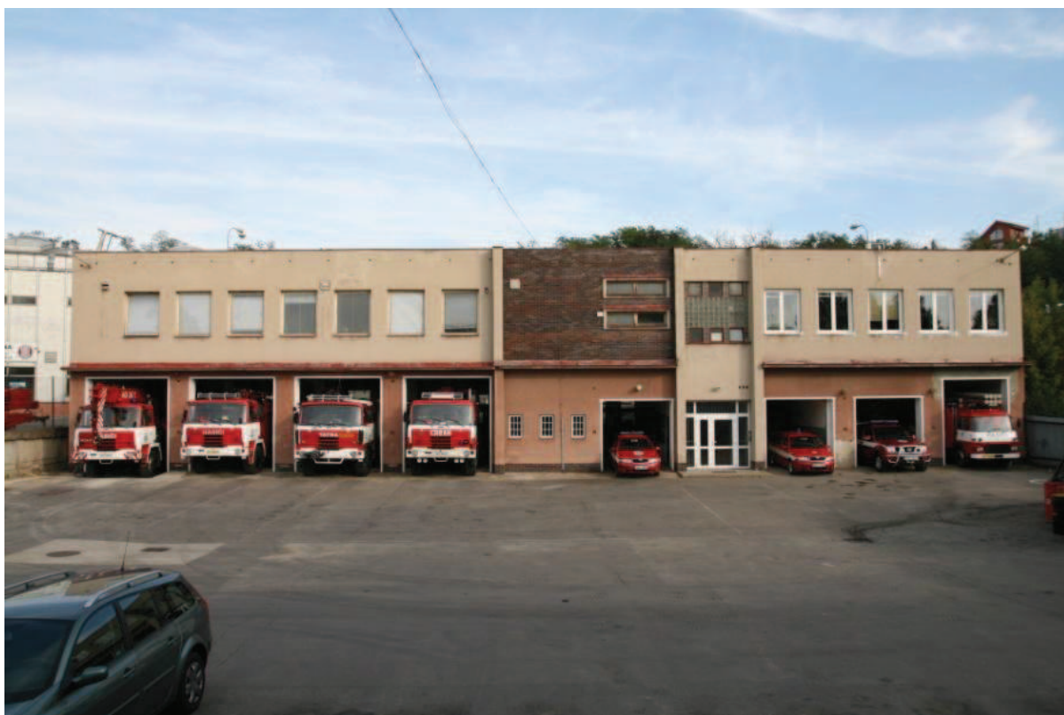
Obr. 4. Budova odborných služeb a garáží JPO HZS SŽDC Brno.
