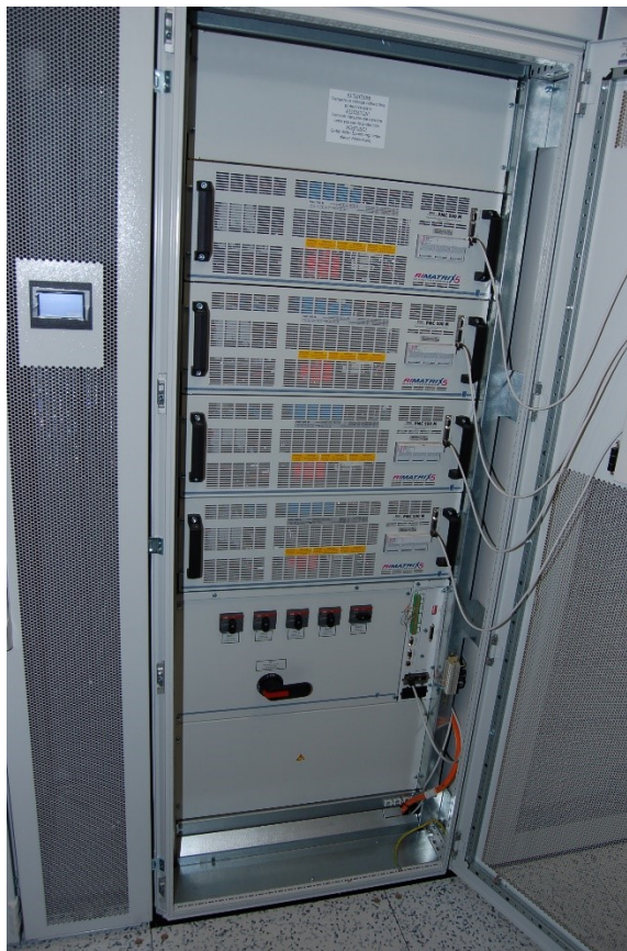
Obr. 28. UPS – výkonové moduly.
