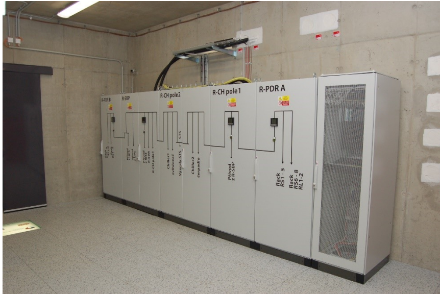
Obr. 27. Elektrotechnické rozvaděče.
