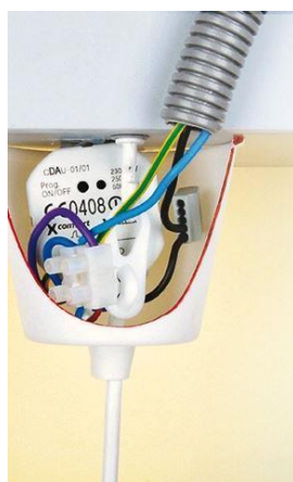
Obrázek 14 Umístění aktoru v osvětlení [28]
