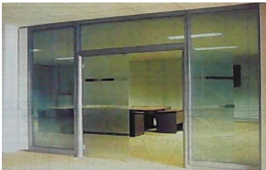
Obr. 17. Průhledná vnitřní prosklená stěna z velkoplošných tabulí protipožárního skla s dveřmi
