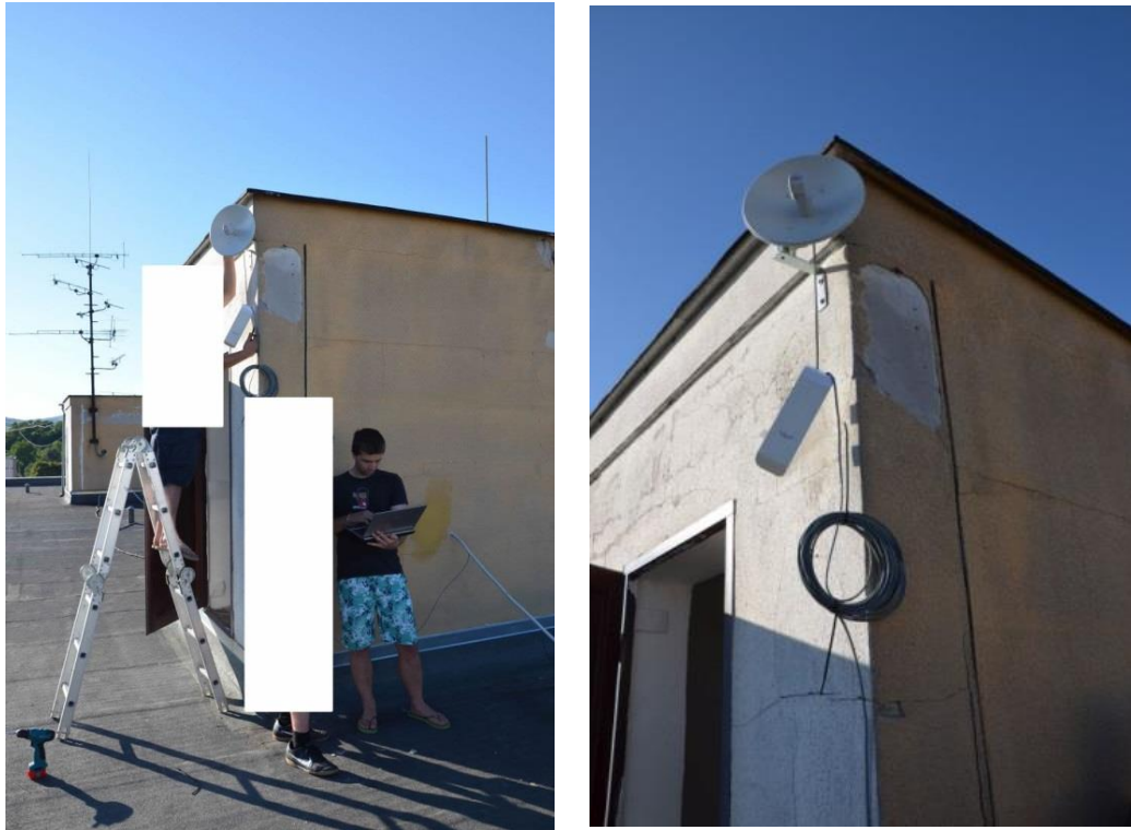
Obrázok 56 – Montáž východzí vysielací bod
