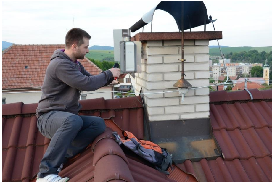
Obrázok 57 – Montáž 1. chrbticový uzol
