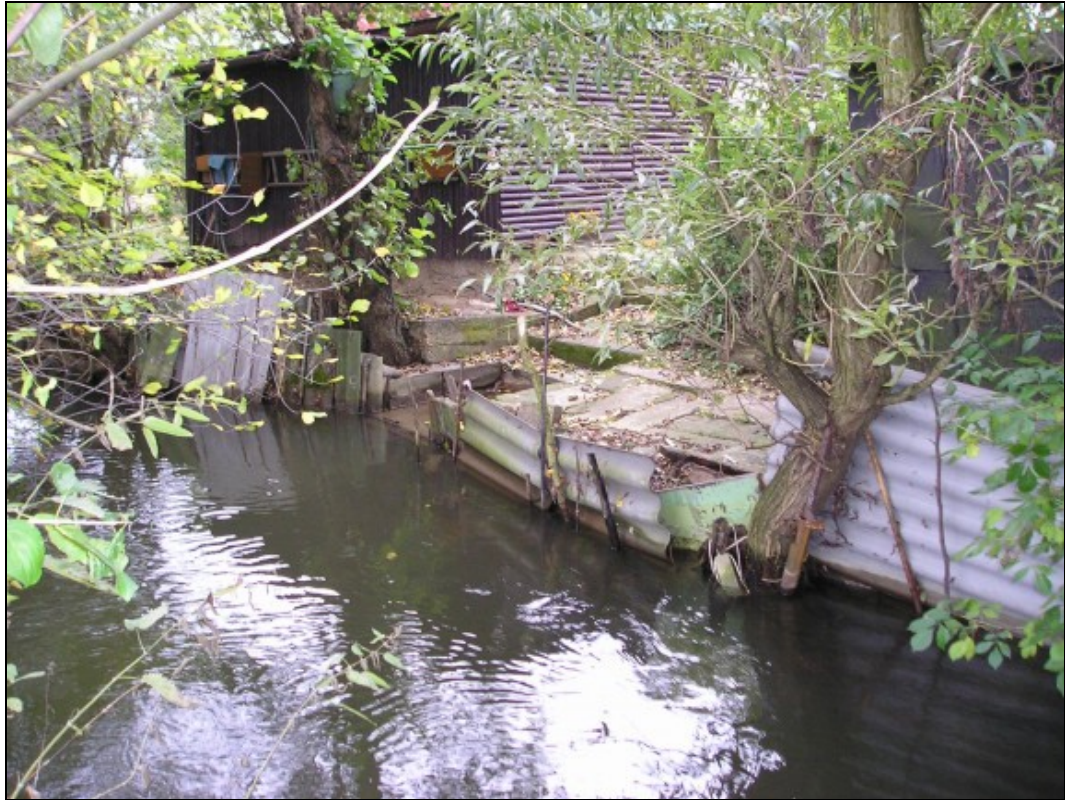
Obr. 8. Černá stavba na břehu řeky Moravy, která zbytečně zatěžuje odtokové poměry v Litovli. [17]
