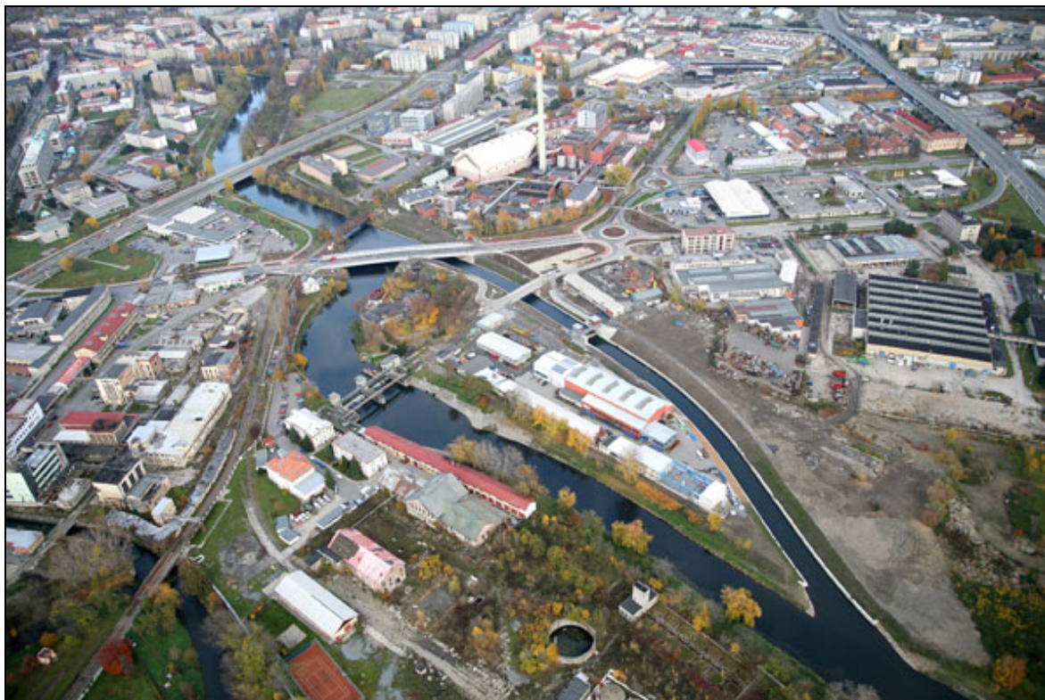
Obr. 11. Již dokončená výstavba obtokového kanálu v průtoku Salzerovy reduty. [19]
