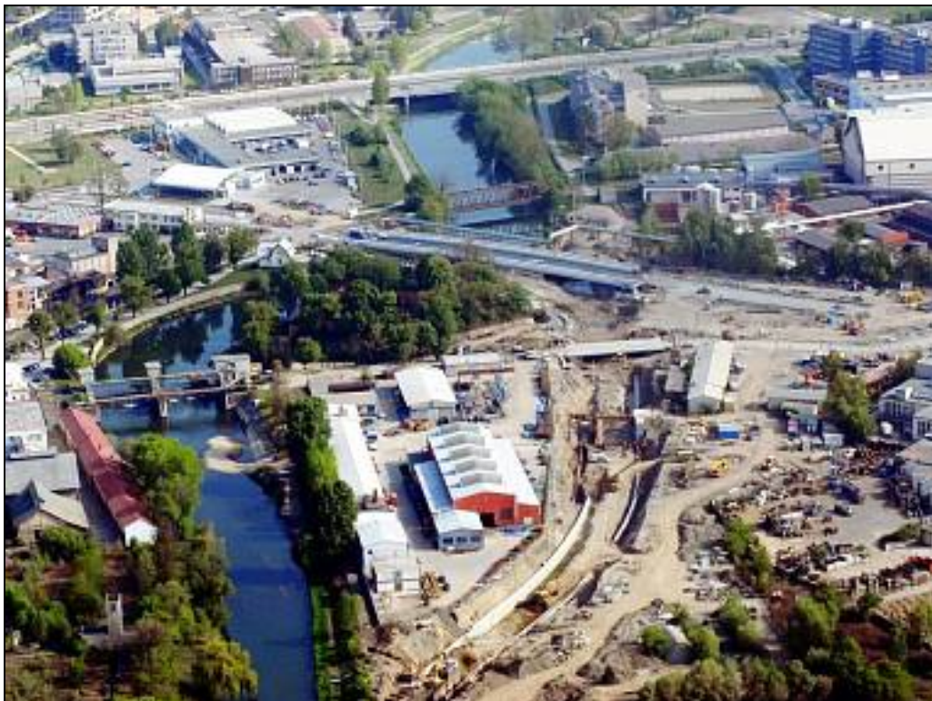
Obr. 10. Začátek výstavby obtokového kanálu v průtoku Salzerovy reduty u Olomoucké teplárny. [19]
