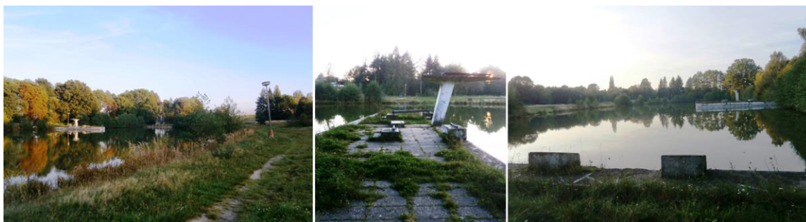
Obr. 5. - 7. Nynější stav koupaliště
