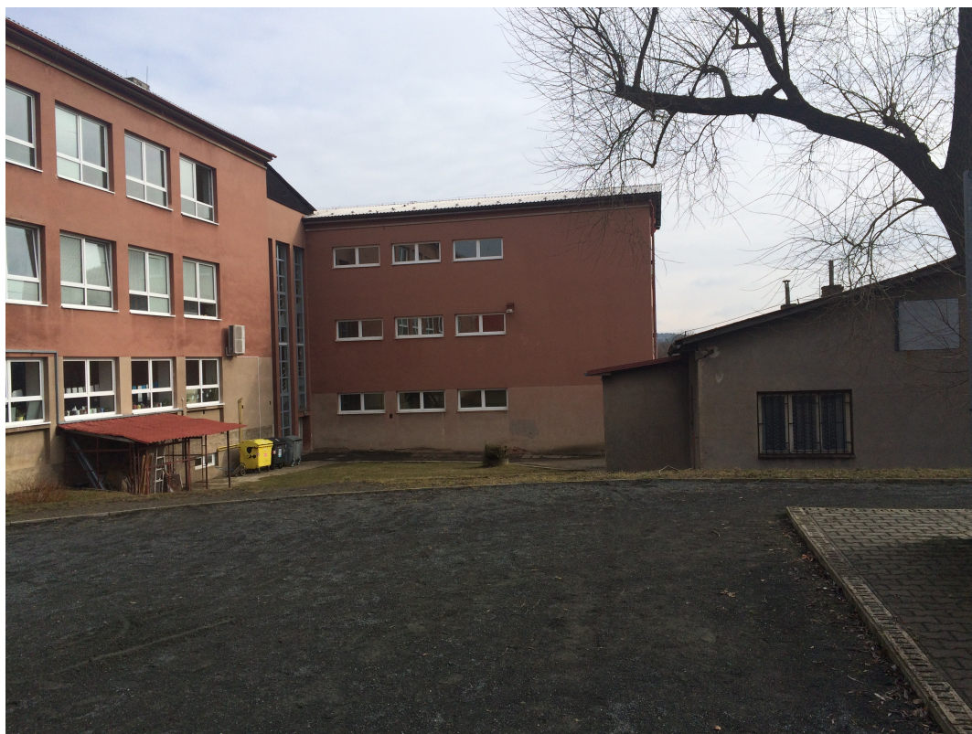
Obr. 16. Jižní strana, pohled na budovy školy (zleva): školička, budova školní jídelny, zde je i stávají příjem zásobování a další budova školy z r. 2015.
