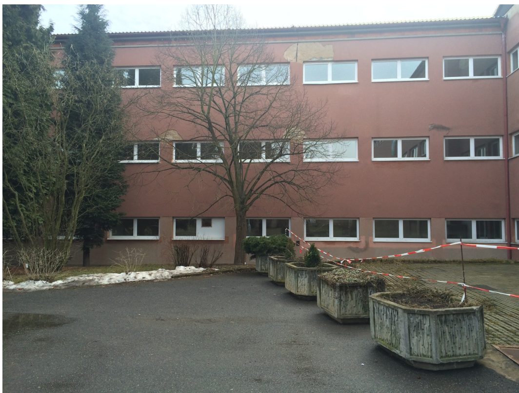
Obr. 15. Jižní strana, pohled na fasádu a okna do provozní chodby a chodby z r. 2015
