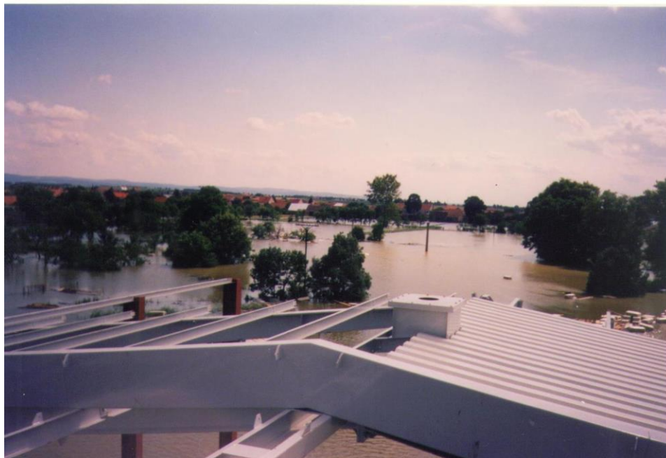
Obr. 39 Povodeň 1997 - pohled ze střechy na zatopený, rozestavěný areál
