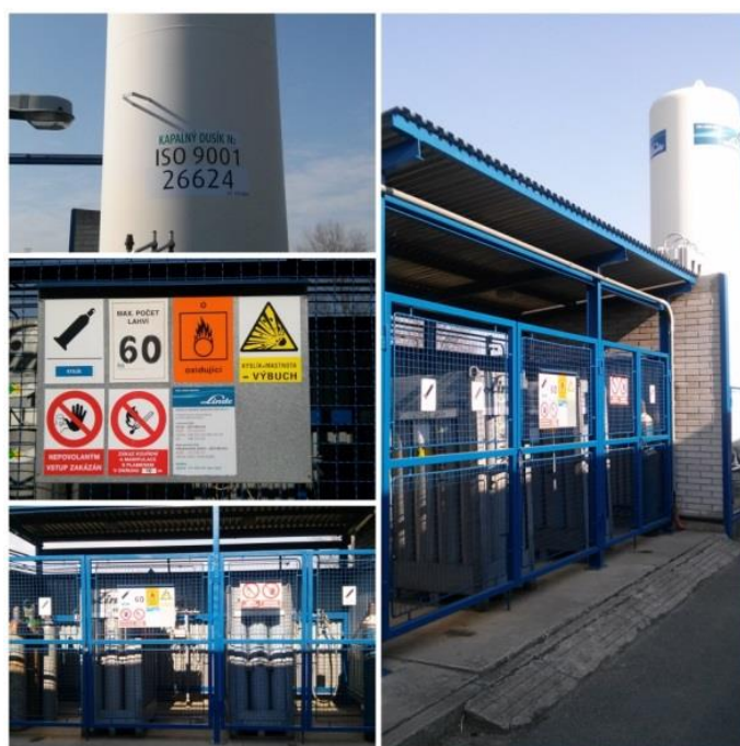
Obr. 38 Odpařovací stanice dusíku [zdroj: vlastní]
