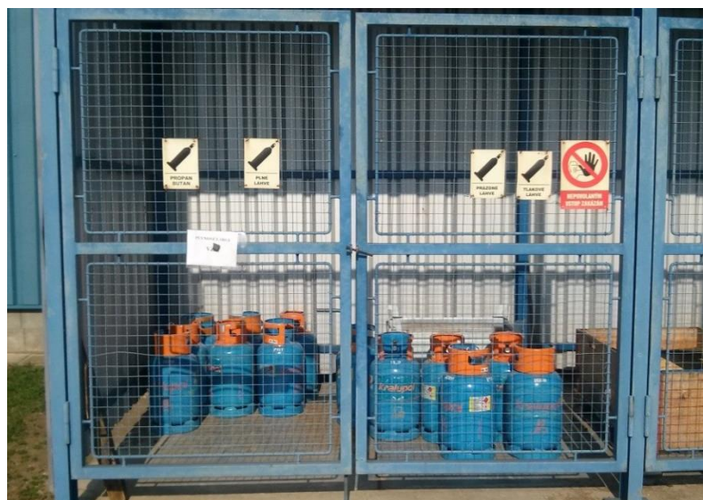
Obr. 35 Otevřený sklad tlakových láhví PB [zdroj: vlastní]
