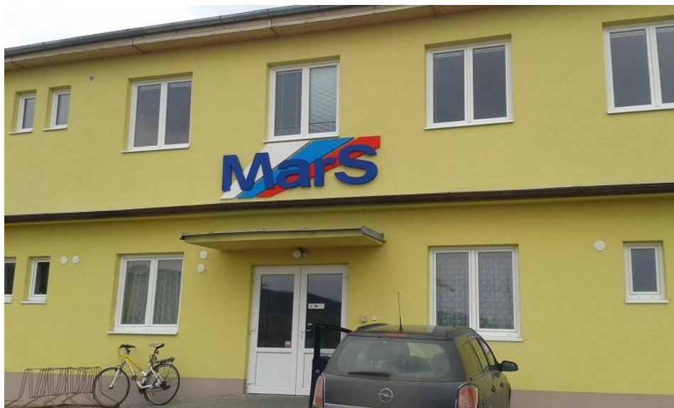
Obrázek 7 Výrobní budova firmy MarS a.s. v Chornicích [14]
