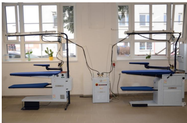
Obr. 15 – Nově zrekonstruovaná prádelna
