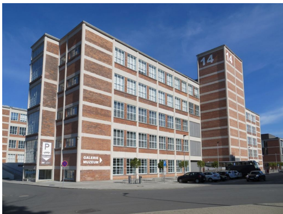
Obr. 1 14. budova továrního areálu ve Zlíně (zdroj: vlastní)
