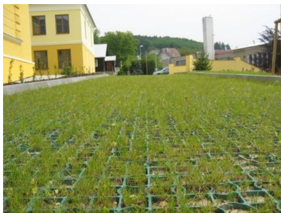
Obr. 13 – Zatravnňovací dlažba společnosti Puruplast [44].
