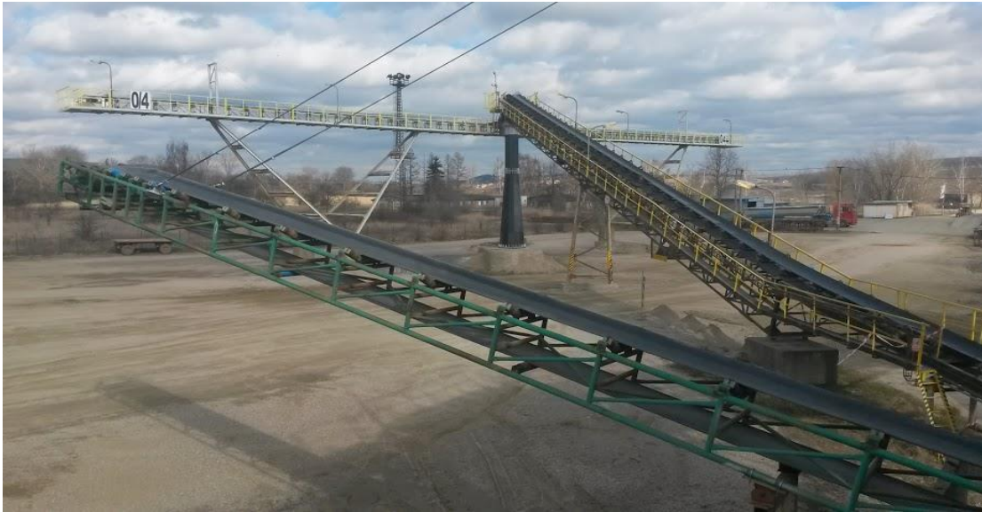
Obrázek 6 Soustava dopravních pásů v úpravně
