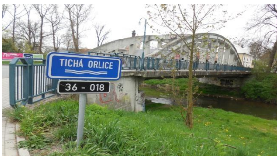
Obr. 14 – Hlavní silniční most směrem na Čermnou nad Orlicí [Zdroj: vlastní]
