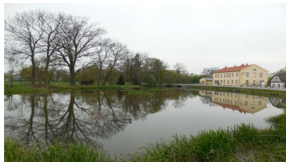
Obr. 13 - Vodní nádrž a soukromá elektrárna [Zdroj: vlastní]
