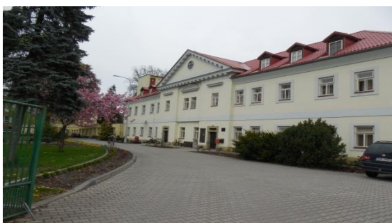
Obr. 15 – Jedna z budov Domova důchodců [Zdroj: vlastní]
