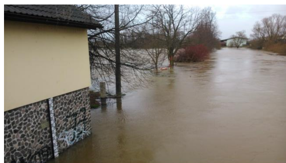
Obr. 33 – Hlásný profil u silničního mostu, záplavy 2015 [Zdroj: vlastní]
