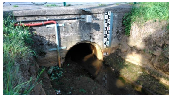
Obr. 25 – Nově instalovaný hlásný profil na silničním mostu [Zdroj: vlastní]
