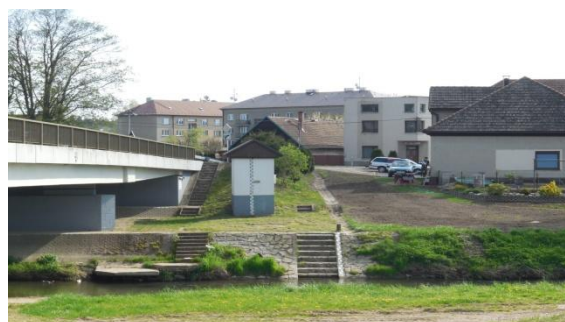
Obr. 20 – Hlásný profil na Tiché Orlici [Zdroj: vlastní]
