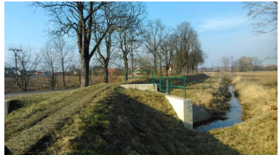
Obr. 3 – Protipovodňová hráz [Zdroj: vlastní]
