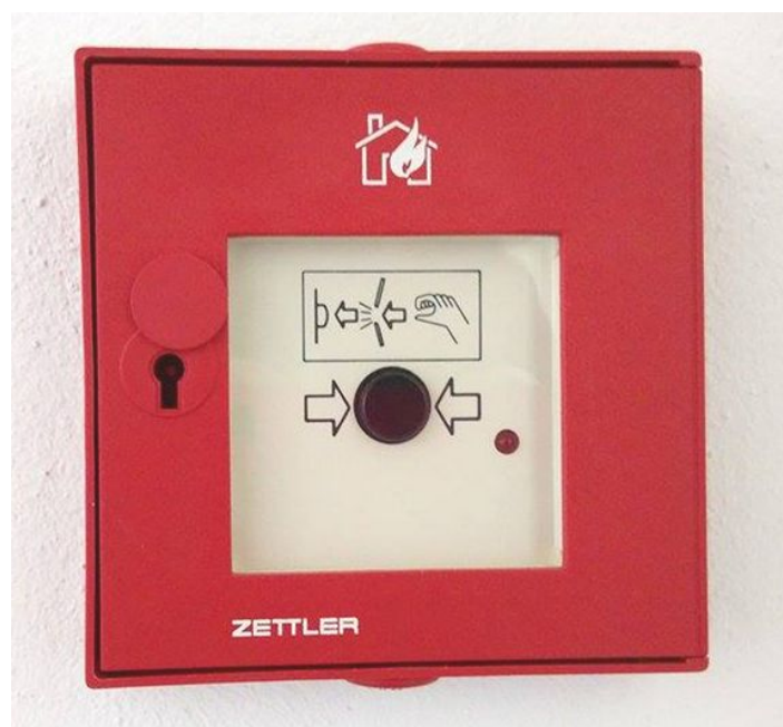
Obrázek 10 Požární tlačítko v budově UH-1 [vlastní]
